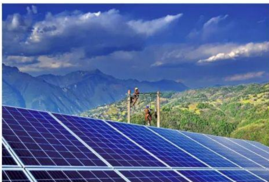
在巴东县溪丘湾乡柳林村，国网湖北供电公司员工架设光伏电站上网线路，服务光伏扶贫电站并网。
